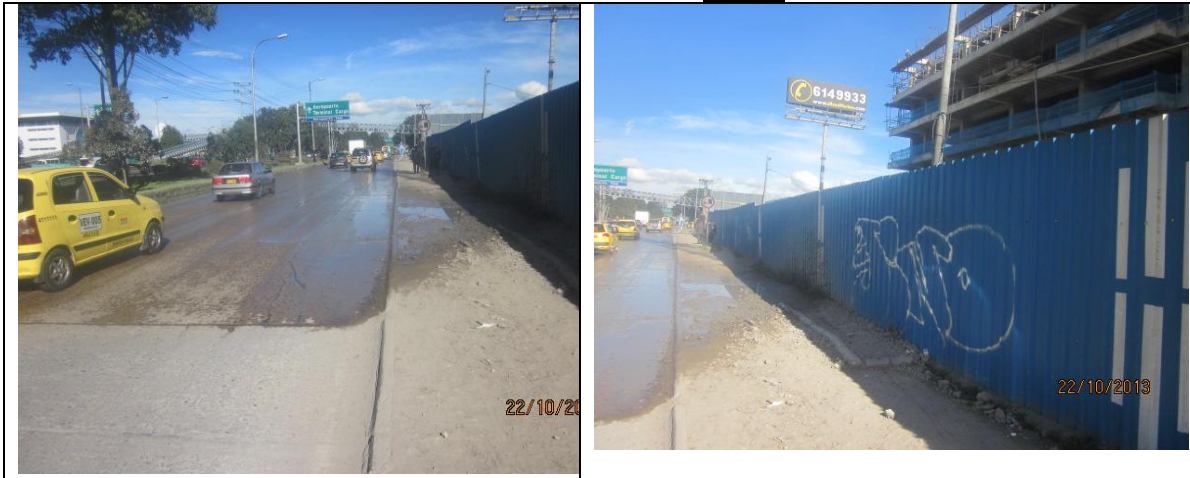
Foto No. 1 y 2. Evidencia de vertimiento de aguas con lodos y material de arrastre
